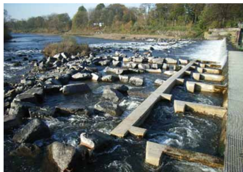
Fischpass und Kontrollstation in Buisdorf an der Sieg
