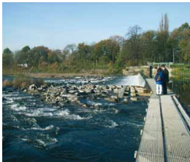
Fischpass und Kontrollstation in Buisdorf an der Sieg
