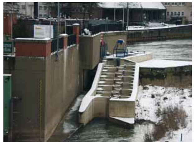
Fischpass an der Pfortmühle in Hameln
