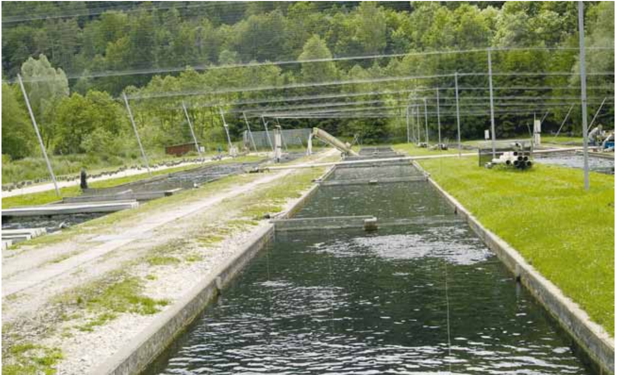
Fließkanalanlage zur Forellenproduktion
