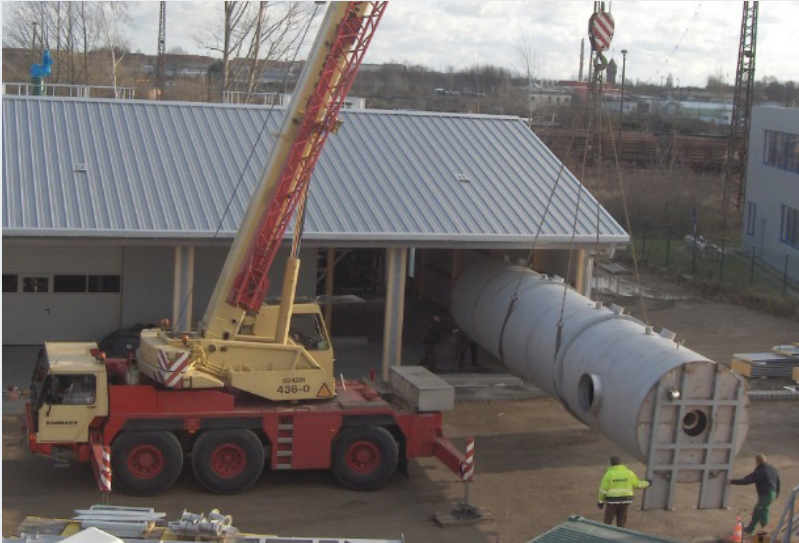
Abb. 5: Einbau eines liegenden Fermenters in die Forschungsbiogasanlage des DBFZ (Foto: DBFZ).
