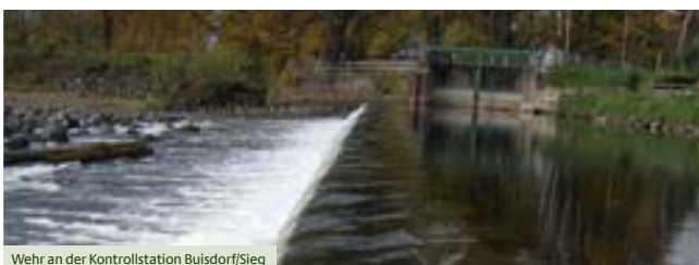
Wehr an der Kontrollstation Buisdorf/Sieg
